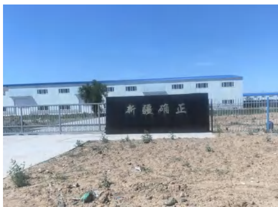
项目区西侧确正新能源公司
